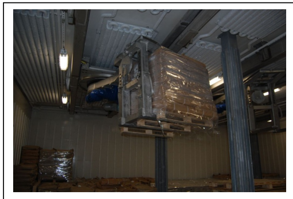
Bilde 12 Kraning til plass i lasterom
